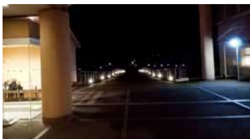
▲照明設置前のスロープ
