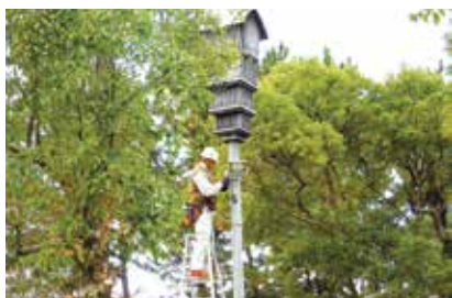
▲照明設置工事の様子
