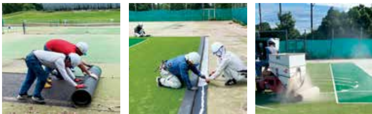
補修工事の様子
